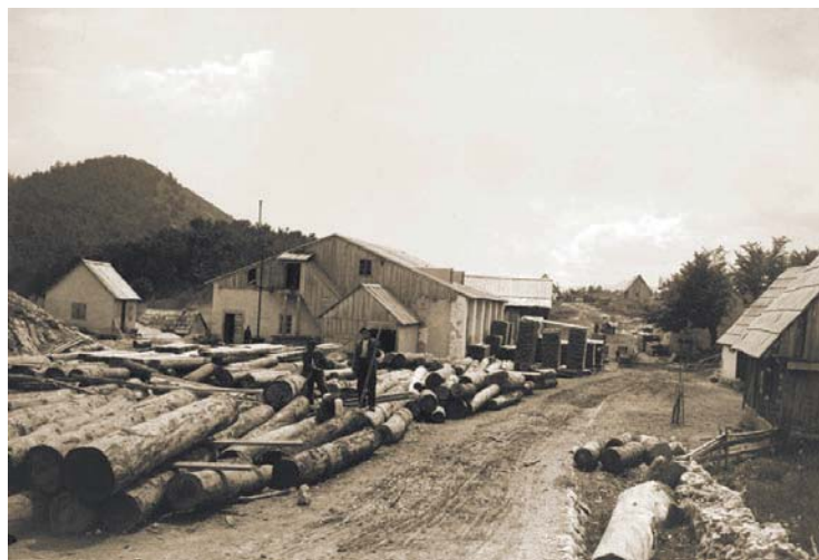
Pilana na Jadovnom – fotografija nastala između dva svjetska rata 17
