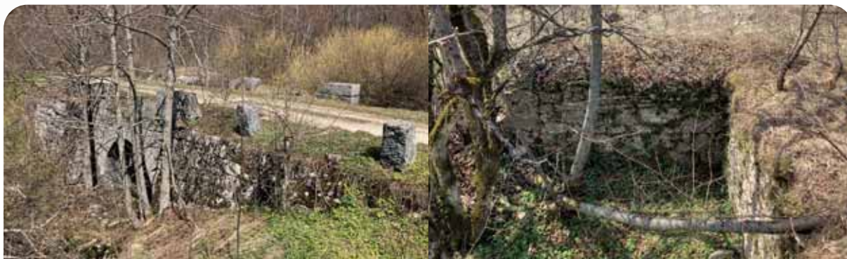
Kameni most u Prijeboju i kamena zidana konstrukcija u koritu potoka
