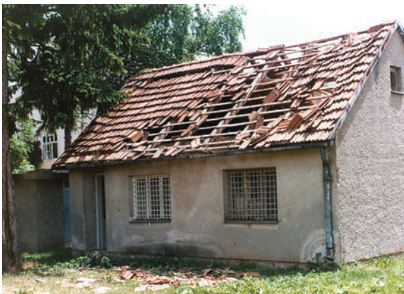
Oštećena pomoćna dvorišna zgrada, 1993.
