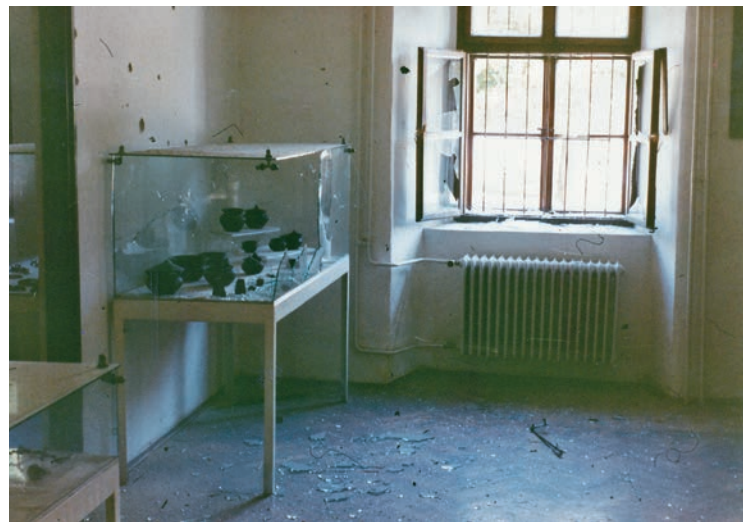
Oštećena unutrašnjost zgrade 1991., prostorija Arheološkog postava
