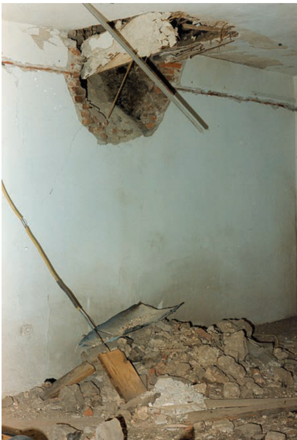
Oštećena unutrašnjost zgrade 1991., galerijski prostor na katu
