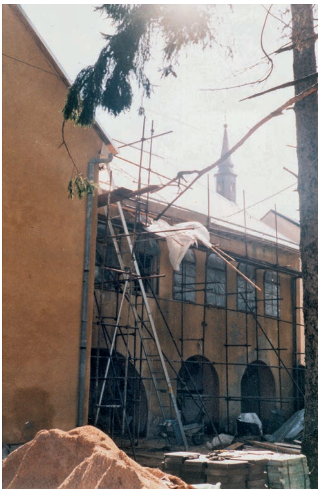
Početak sanacije i adaptacije zgrade Muzeja, 1995.
